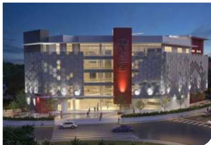
2020 Inicio de construcción del edificio de Ingenierías.
